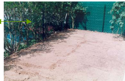
Étape 4 Après damage
